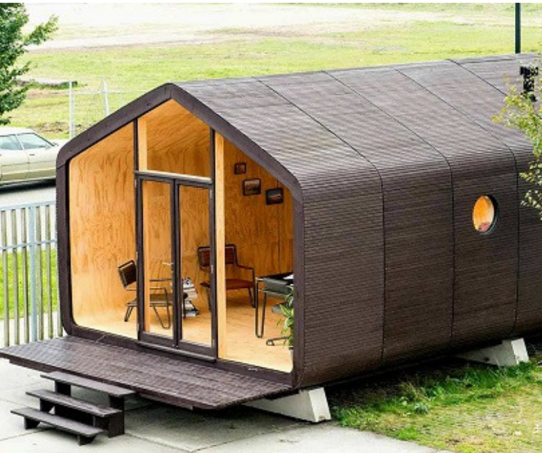
C'est une maison construite à partir de carton recyclé, c'est pourquoi elle est appelée « Wikkellhouse » afin de respecter le HQE.
